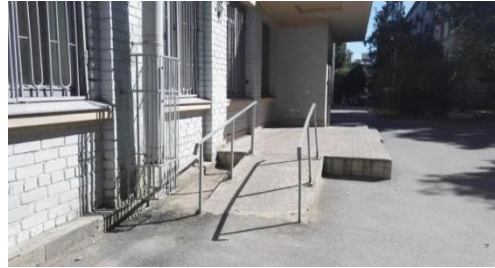
Пандус на крыльце здания
